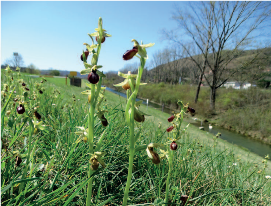
Fig. 8. Les digues du Rhône, aménagées pour l'hydroélectricité et la navigation, peuvent rendre d'autres services: biodiversité (orchidées), loisirs, pastoralisme... (Photo: J.-L. Michélot).
