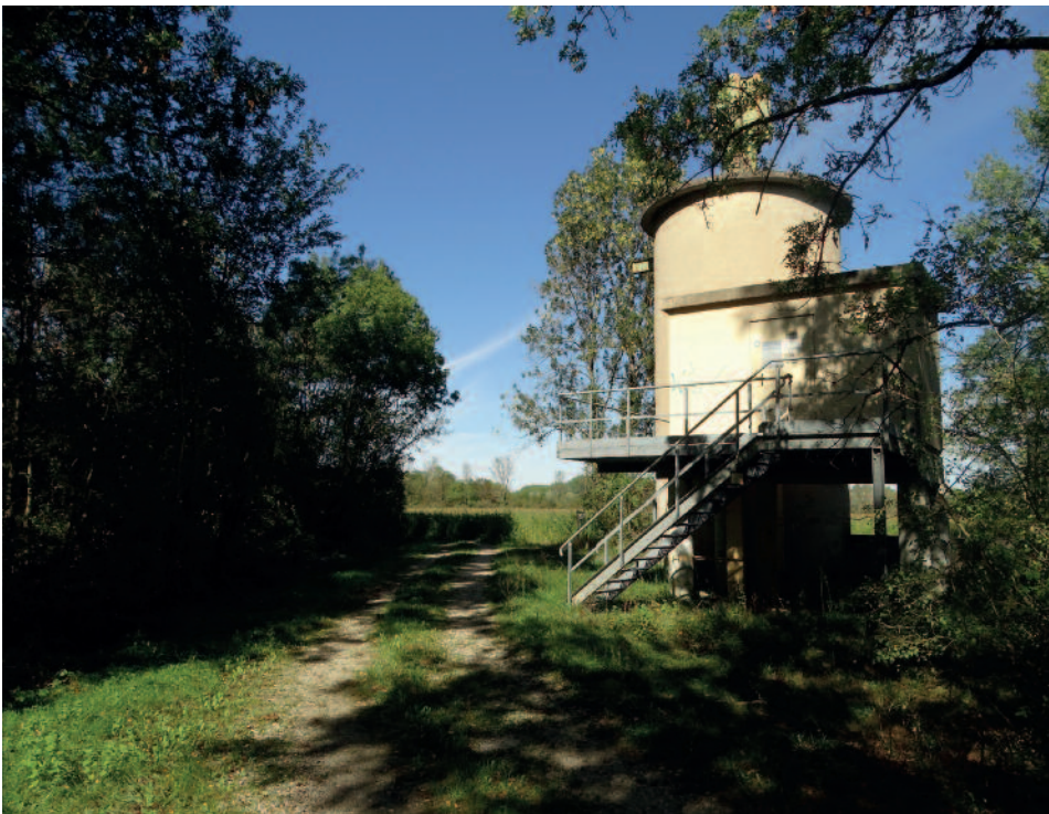
Fig. 7. Antagonismes entre services: les captages destinés à l'industrie chimique abaissent la nappe phréatique, portant atteinte à la forêt alluviale et à ses fonctions (biodiversité, régulation...). Ile de la Platière, moyenne vallée du Rhône.
